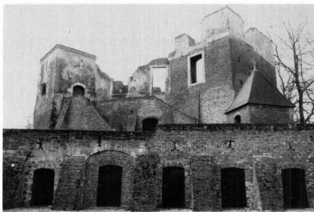
Figuur 10. De ruïne van de Keveborg in Kessel.
